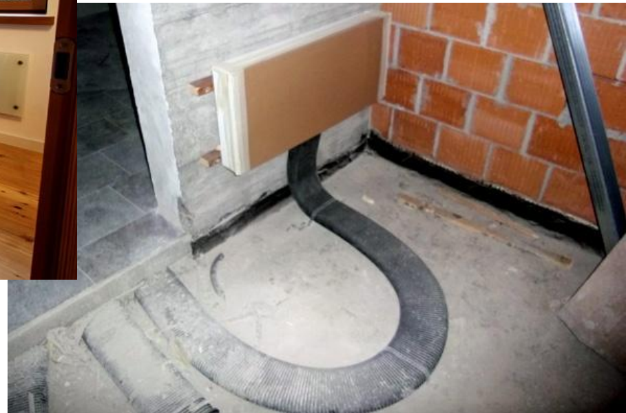
Distributori VMC con riscaldatori integrati
